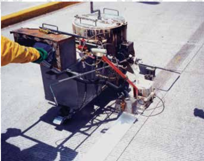
Aplicación de pintura termoplástica con máquina manual modelo MAN - 50
