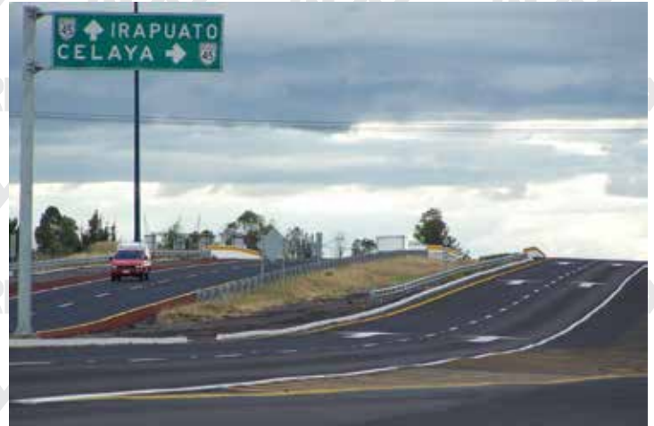
Aplicación de pintura de tráfico líquida con máquina autopropulsada modelo AUT - 30
