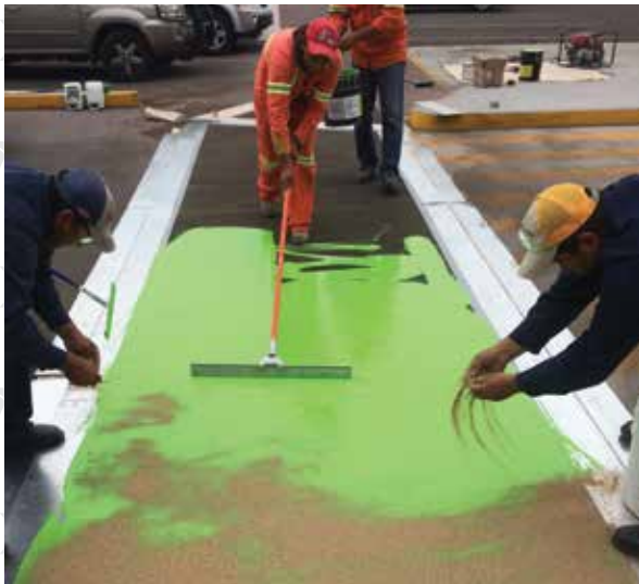
Aplicación de Pintura Metilmetacrilato (MMA) o Plástica en frío.
