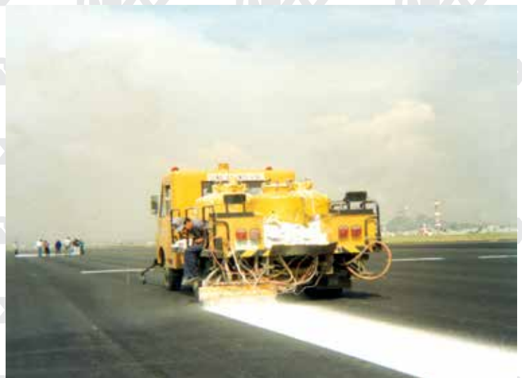
Aplicación en aeropuertos de pintura de tráfico líquida con máquina autopropulsada modelo AUT - 40
