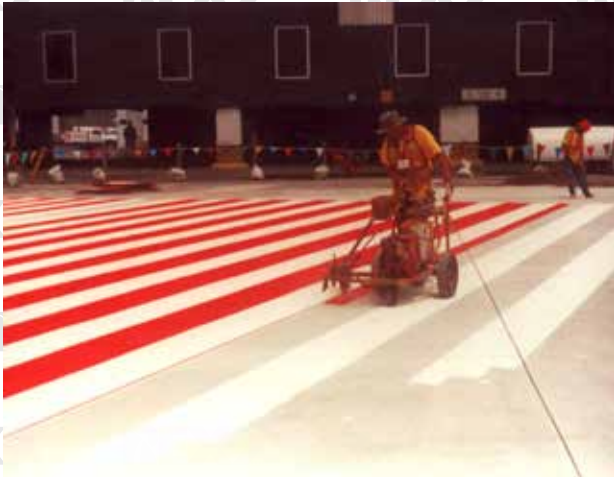
Aplicación de pintura de tráfico líquida con máquina manual modelo MAN -08
