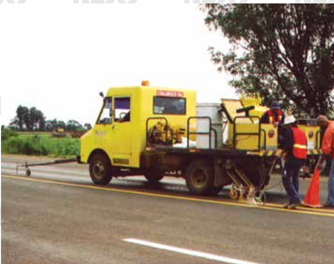
Aplicación de pintura de tráfico líquida con máquina autopropulsada modelo AUT - 40
