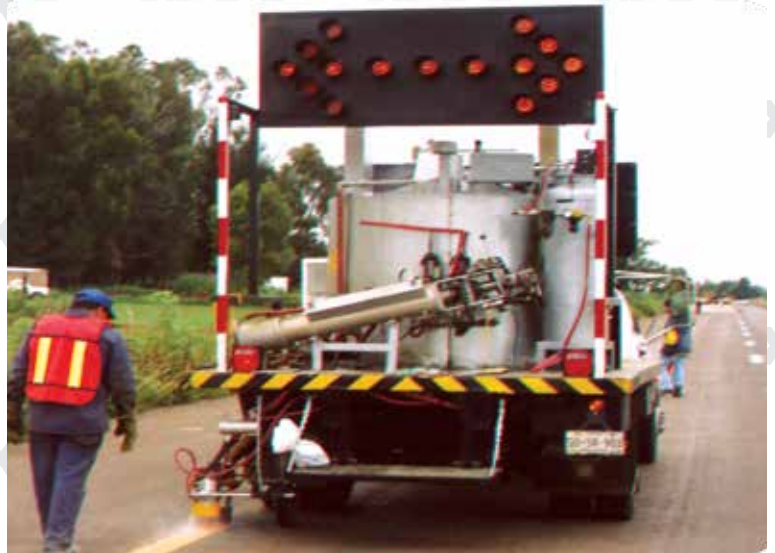
Aplicación de pintura termoplástica con máquina autopropulsada modelo AUT - 60
